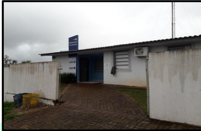
Figura 03 – Fachada Unidade de Saúde Alto São Mateus (Fonte: Autores, 2018).
