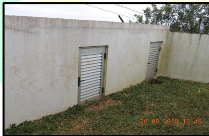
Figura 12 – Depósito utilizado para armazenamento dos resíduos da Unidade de Saúde Alto São Mateus. (Fonte: Autores, 2018).
